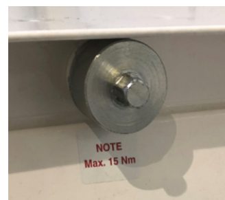
Filterinspänning, max. 15 Nm
